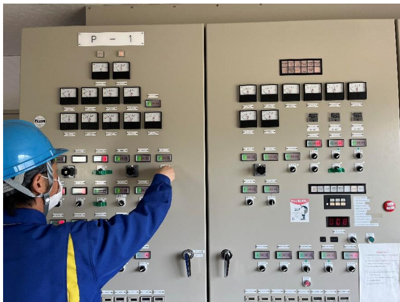
図3.技術点検員による制御盤の点検
